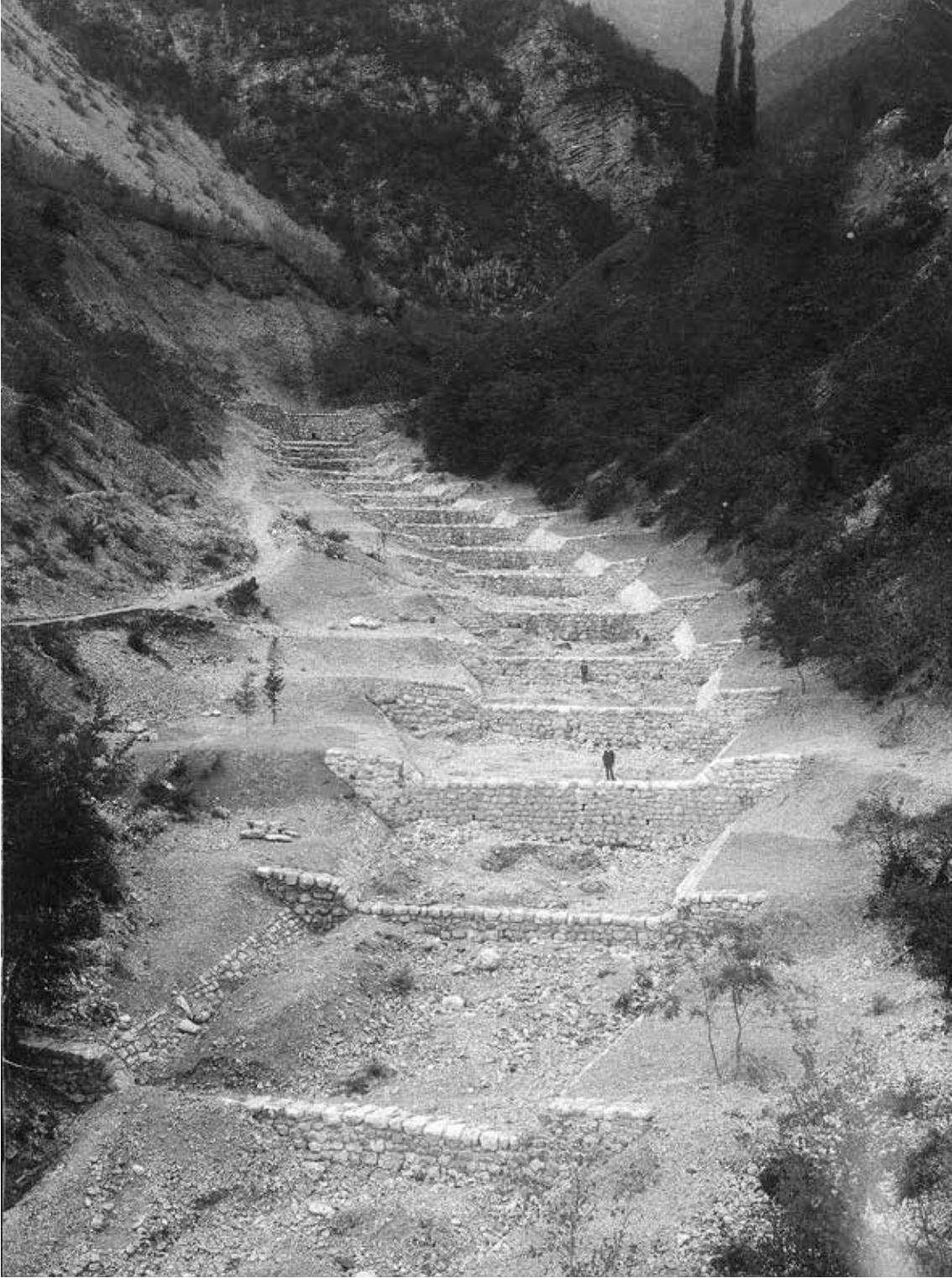
Opere di sistemazione realizzate agli inizi del Novecento sul torrente Magnone nel comune di Tenno.
