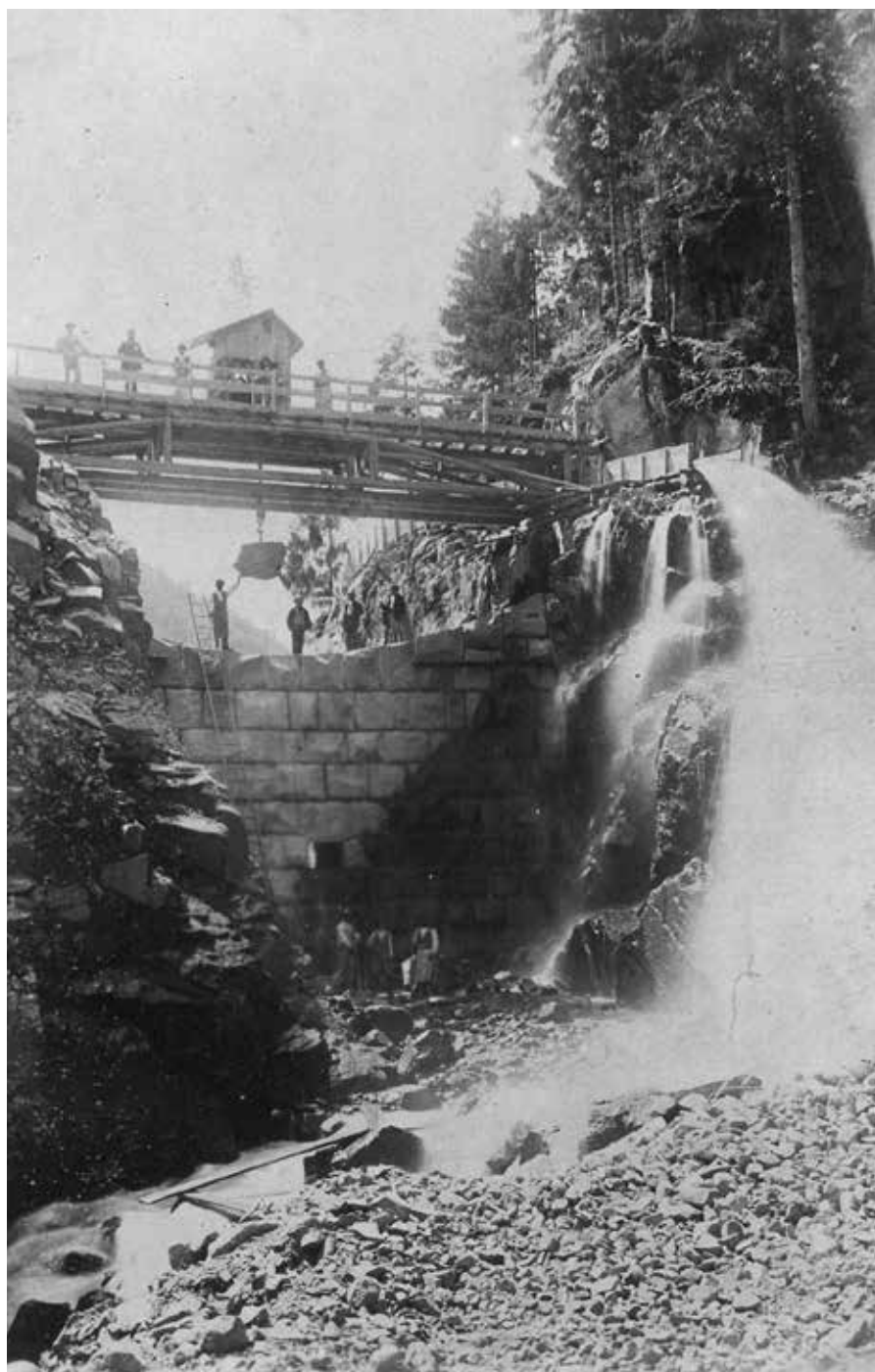
1890: lavori di realizzazione della serra sul rio di Brusago.
