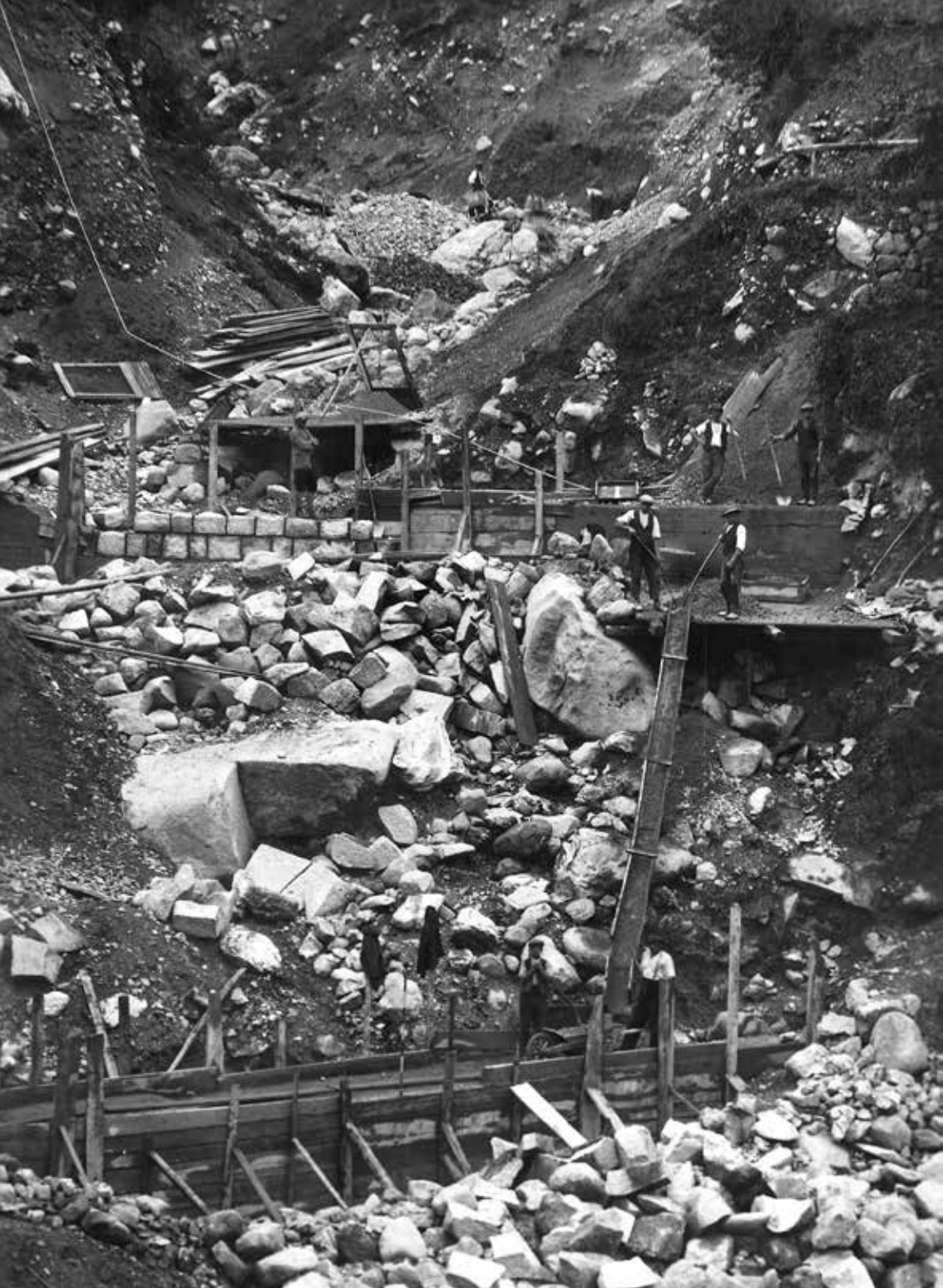
1928: briglie in costruzione sul rio Valvassé a Ragoli.
