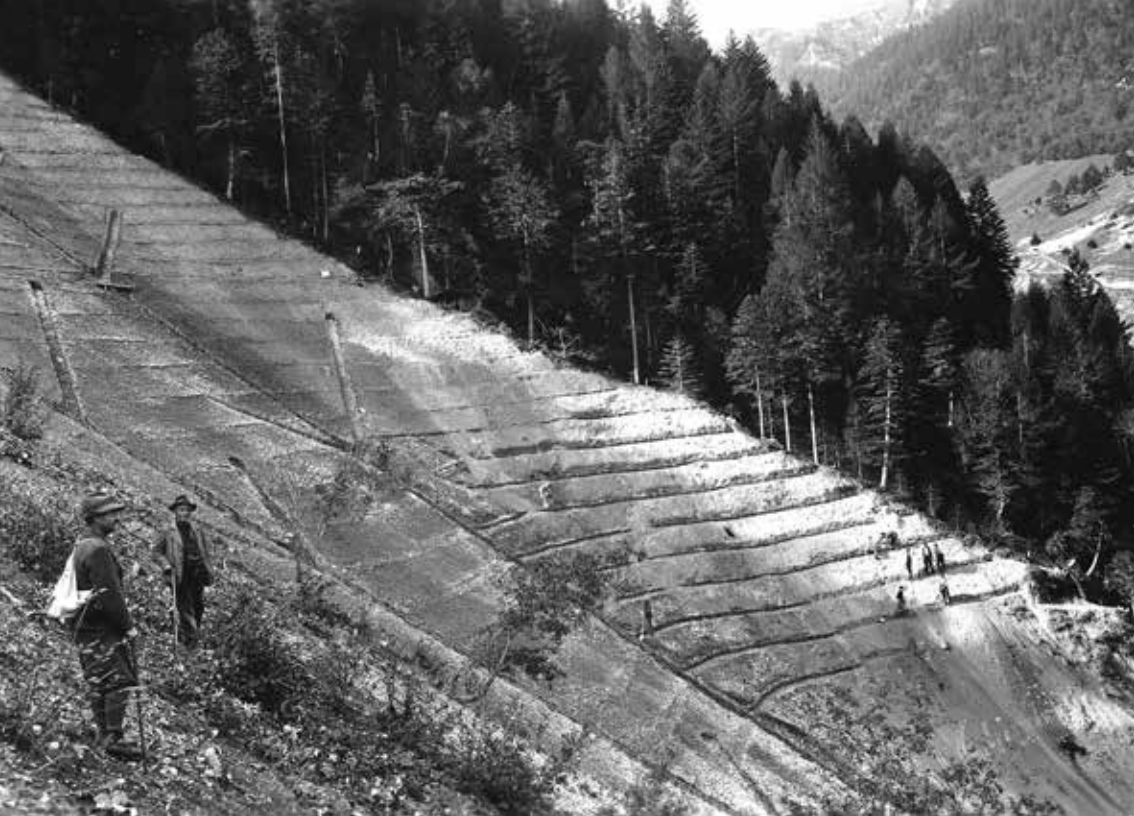
1936: intervento di sistemazione di una frana nel bacino idrografico del torrente Adanà, sopra Roncone.
