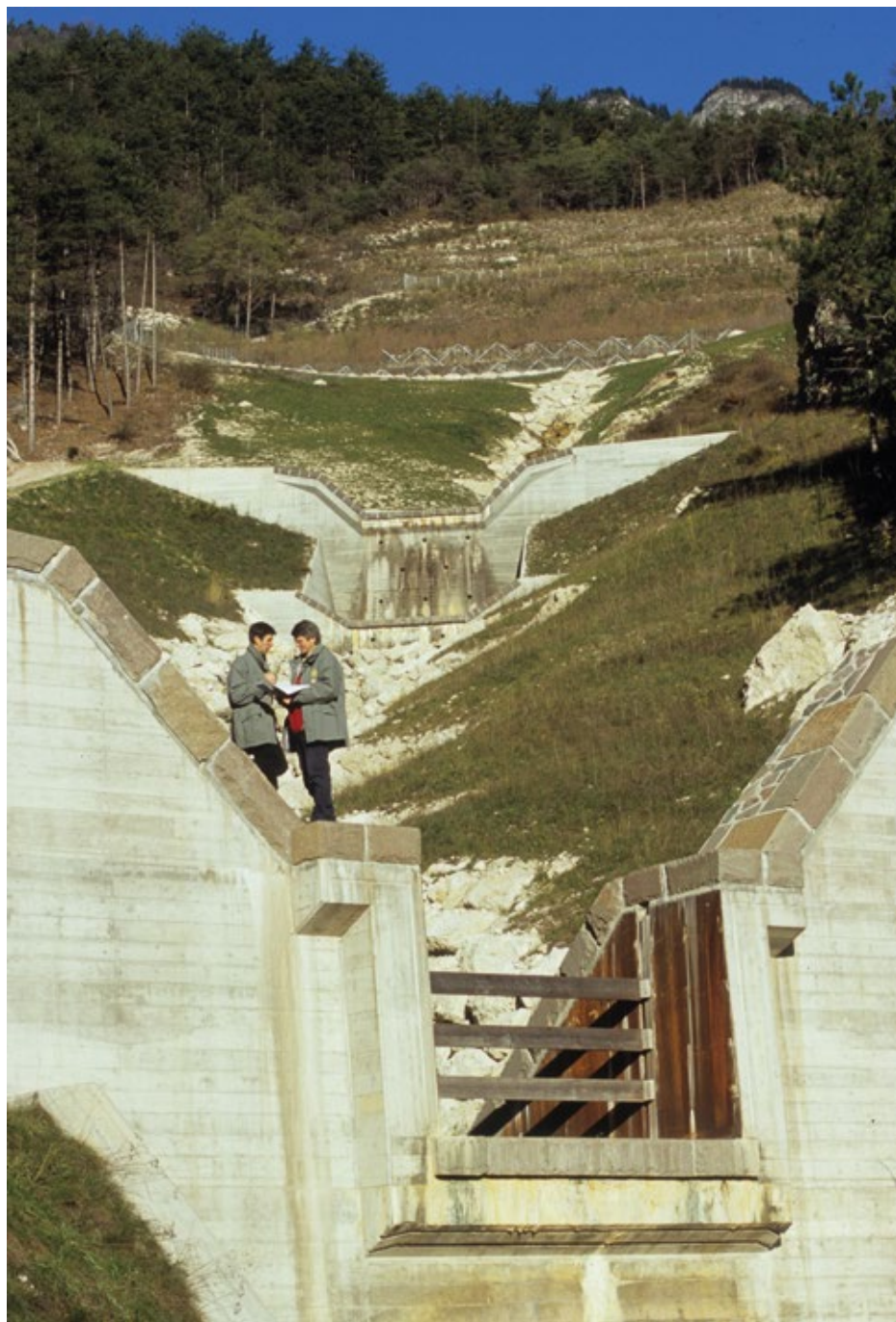
Momento di consulto tra funzionari del Servizio Bacini Montani durante i lavori di sistemazione del rio Molini a Roverè della Luna.
