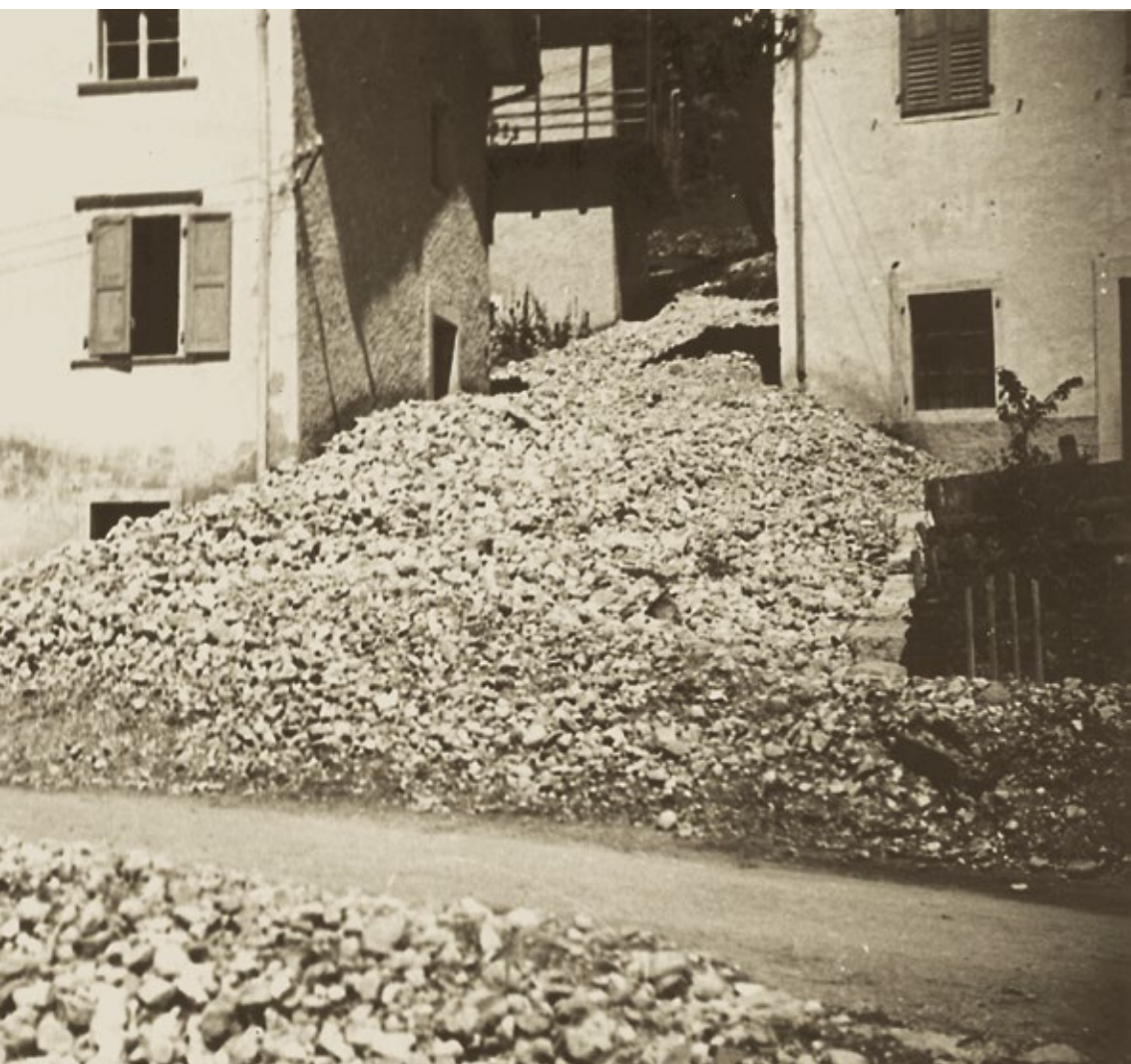
Piazza, frazione di Terragnolo, a seguito dell'alluvione del 1938.
