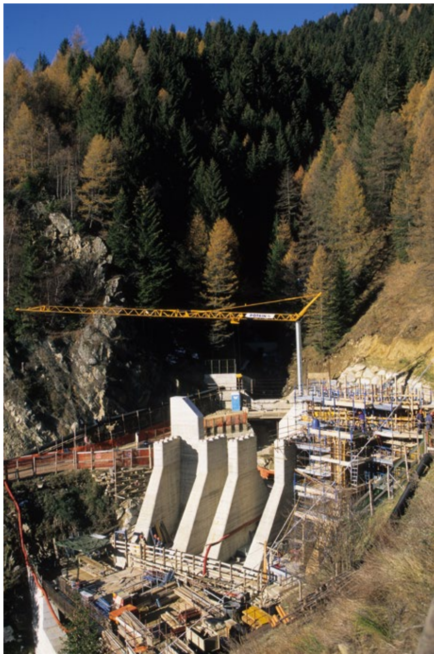
Cantiere per la realizzazione di un'opera con funzione di arresto, trattenuta o laminazione di colate detritiche e altri trasporti di massa sul rio Cortina a difesa dell'abitato dell'omonima frazione nel comune di Vermiglio.
