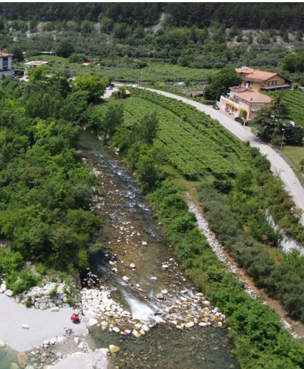
Lavori di recupero ambientale sul fiume Sarca nei pressi della biblioteca di Dro.
