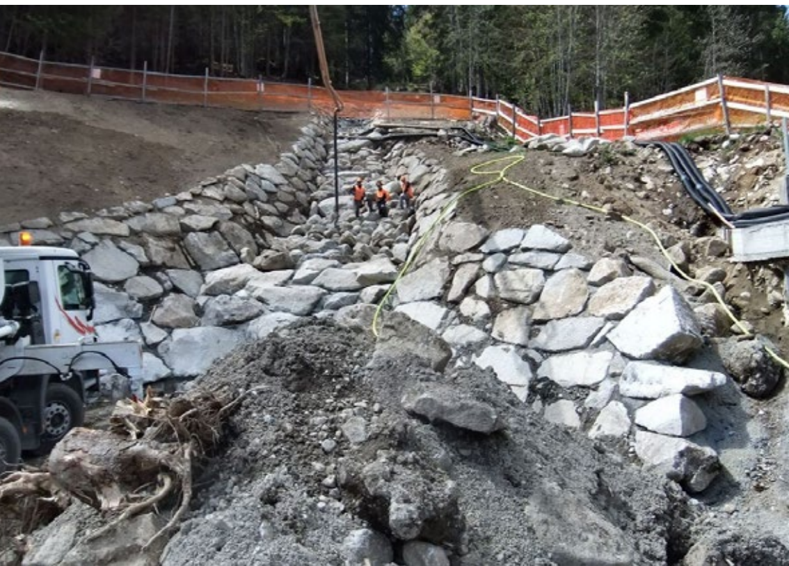
Agosto 2021: lavori di sistemazione idraulica del rio Patascoss a Madonna di Campiglio allo scopo di ridurre le criticità generate dal corso d'acqua.
